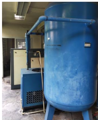
ภาพที่ 41 เครื่องปั๊มลมแบบสกรู 37 HP
