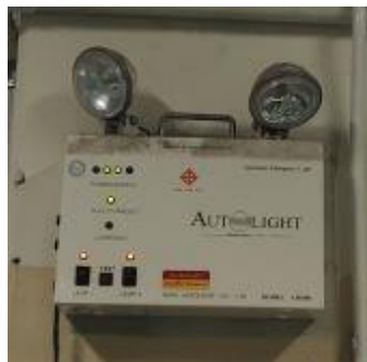
ภาพที่ 17 ไฟแสงสว่างฉุกเฉิน
