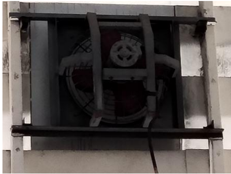
ภาพที่ 13 พัดลมระบายอากาศขนาดใหญ่
