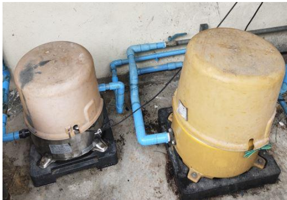
ภาพที่ 20 ปั้มน้ำแรงดัน
