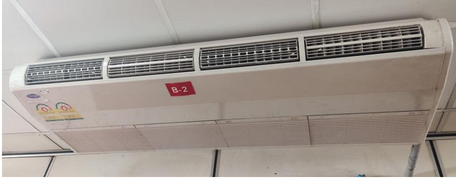
ภาพที่ 9 เครื่องปรับอากาศ
